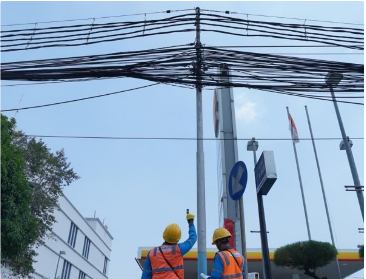
Photo: Titik Lokasi pencuri Kabel PLN
