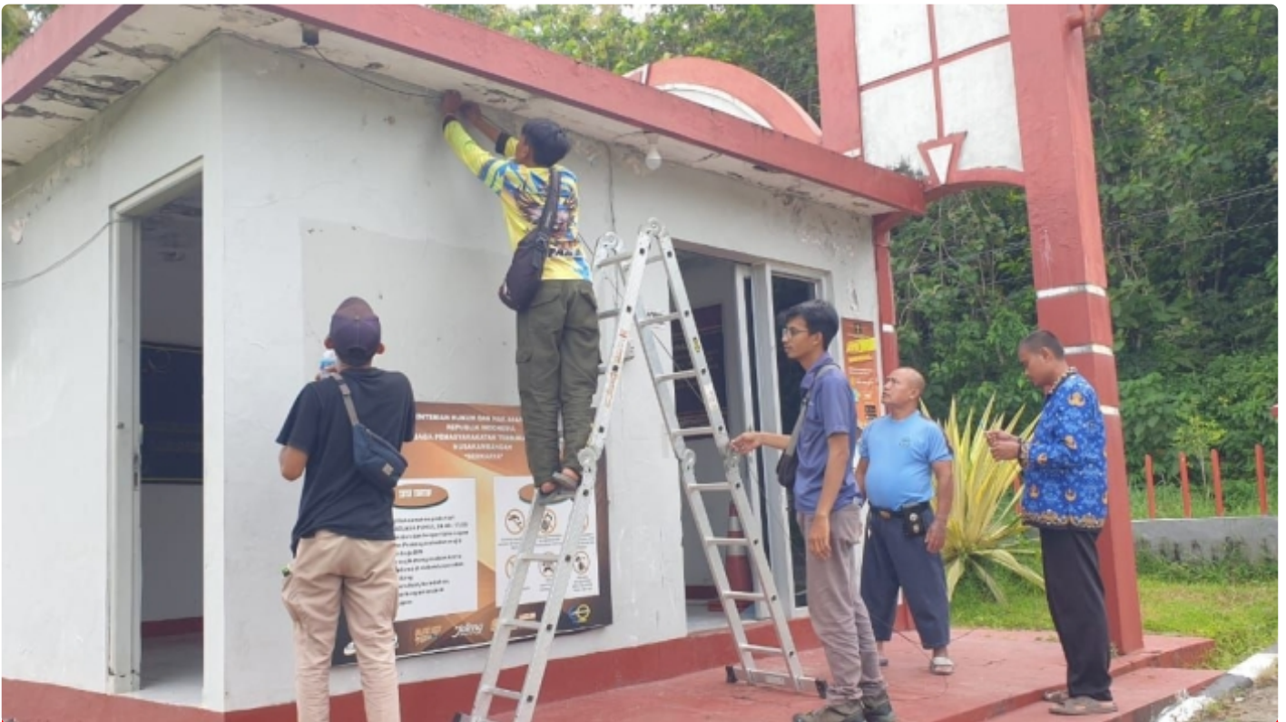
Pemasangan CCTV,DVR,dan NVR Oleh Petugas
